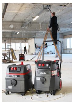
Støvsugere Støvsugere med "H"-klassificering til farligt støv.
