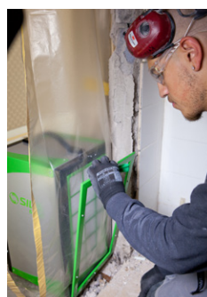
Luftrensere Skaber undertryk i asbestzone og renser luften igennem filtre.
